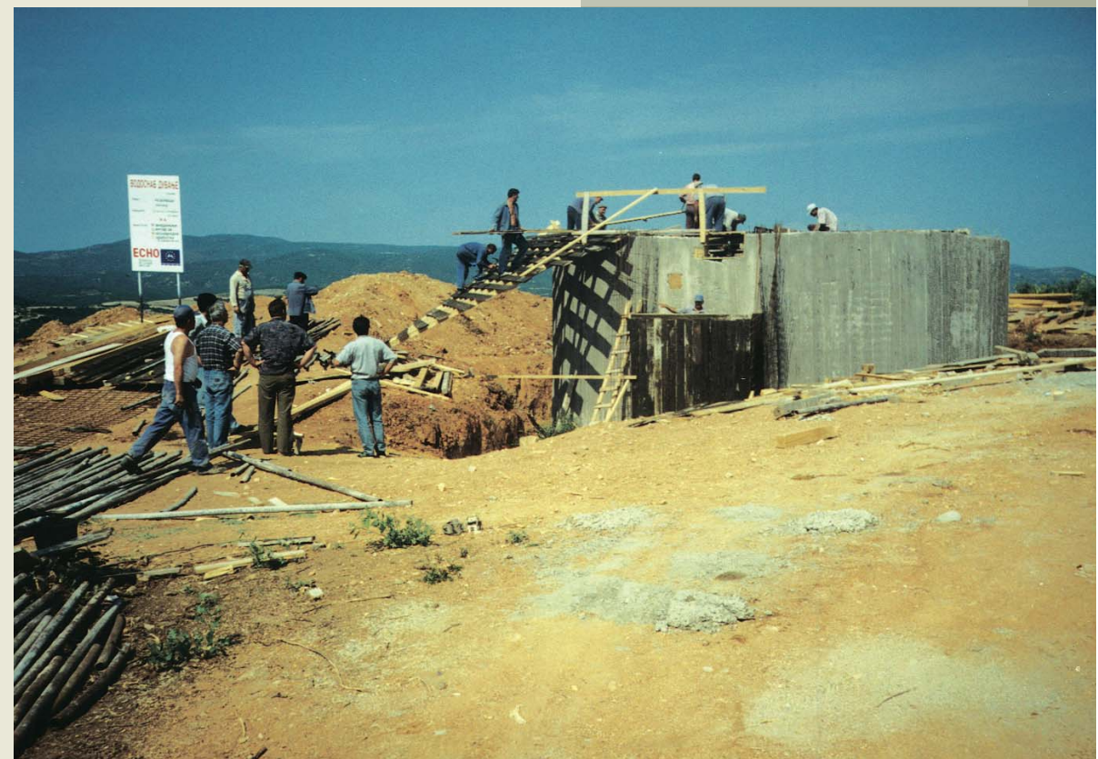
Изградба на резервоар во с.Едрениково ▶
